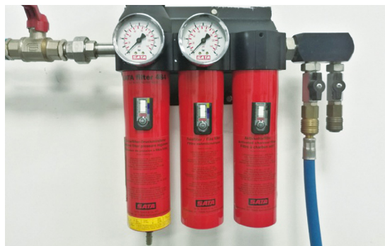
图24 终端油水分离器维护完成
